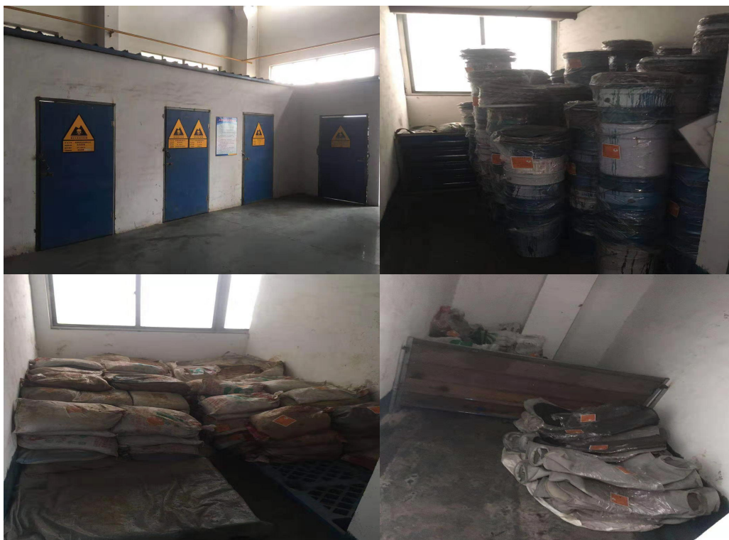
图7-1 公司危险废物仓库照片
