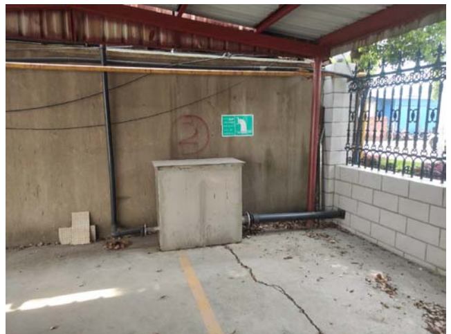
在线监测仪废水接管口
