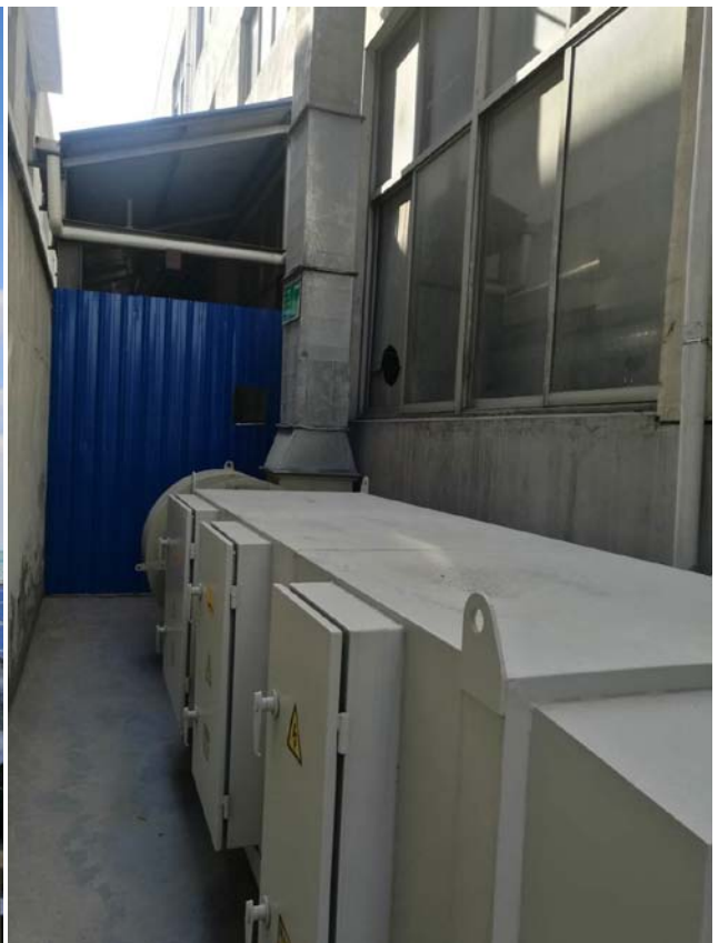
3#排气筒（低温等离子+UV 光氧催化装置）
