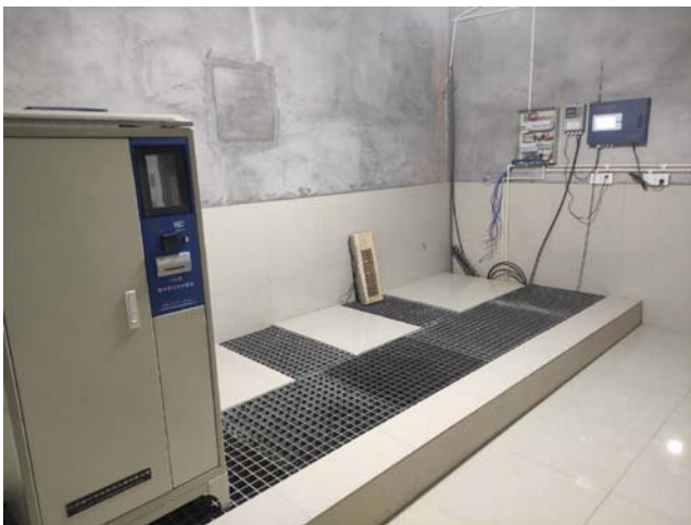
在线监测仪废水接管口
