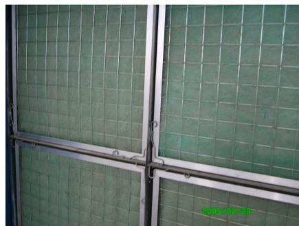
图 5-4 玻纤漆雾过滤器
