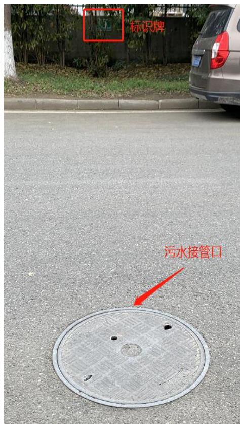
污水接管口及标识牌：
