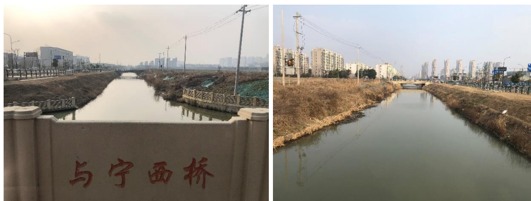
图 3-3 大寨河河道两岸现状图
