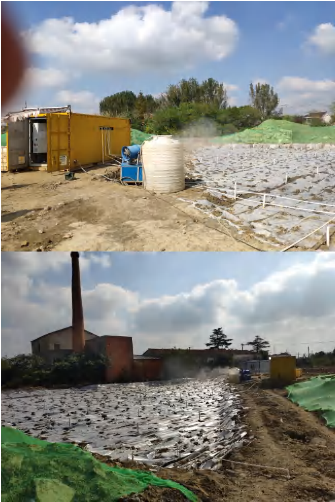
图 4.2-1 修复完成后项目现场
